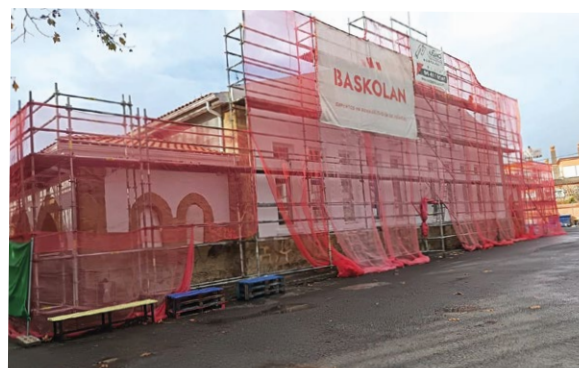
Comienzan las obras del Centro Ocupacional Donibane
